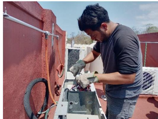
**Figura 62.** Cambio de condensadores.
