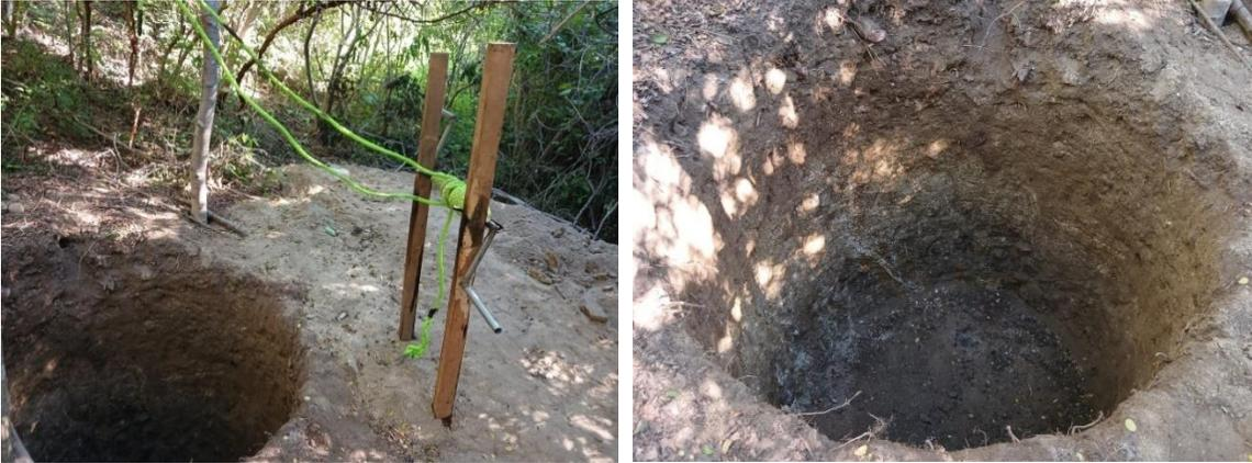
**Figura 83.** Inicio de excavación de un pozo noria.
