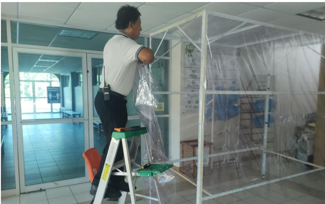
Figura 40. Construcción de filtro sanitizante.
