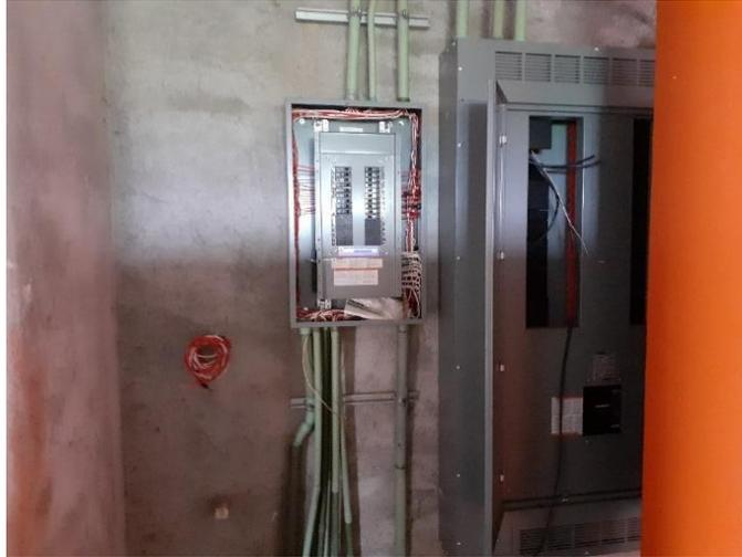
*Fotografía 19. Instalación de la red eléctrica.*
