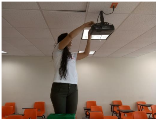
Imagen No. 10. Mantenimiento a proyectores de las aulas
