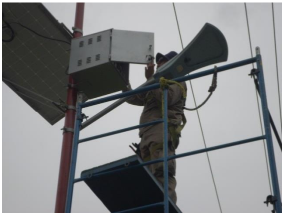
Figura 58. Mantenimiento a lámparas solares del acceso principal.
