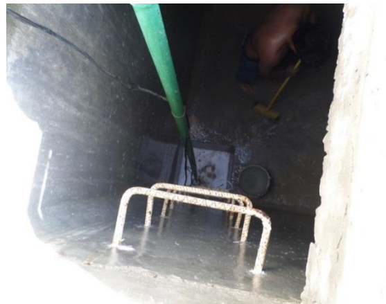
Figura 61. Mantenimiento de cisterna de agua para uso humano.
