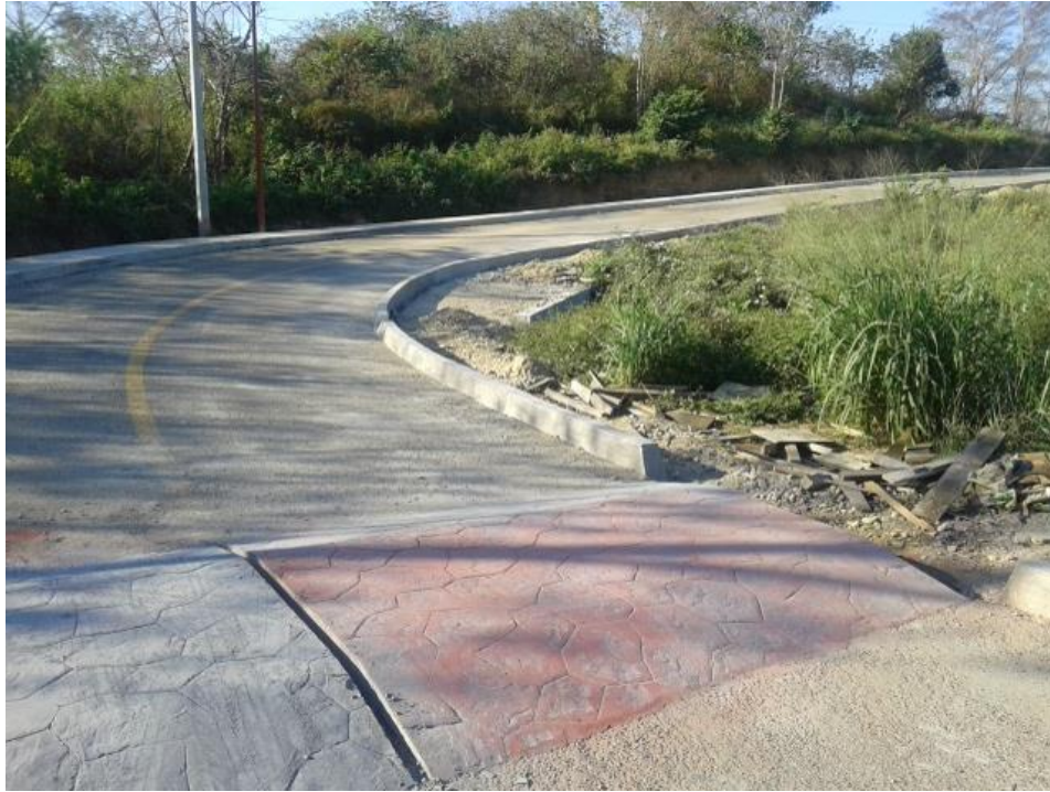
Figura 63. Reductores de velocidad con cambio de dirección.
