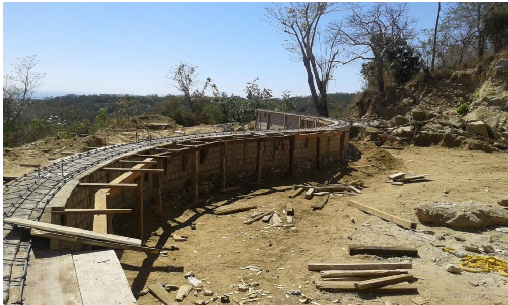
Figura 17. Muro de contención del Centro de Cómputo.
