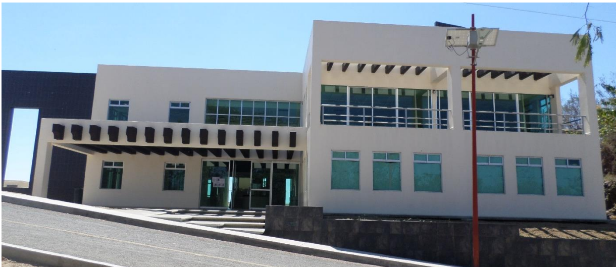
Imagen No. 9. Edificio de Cómputo tipo L.
