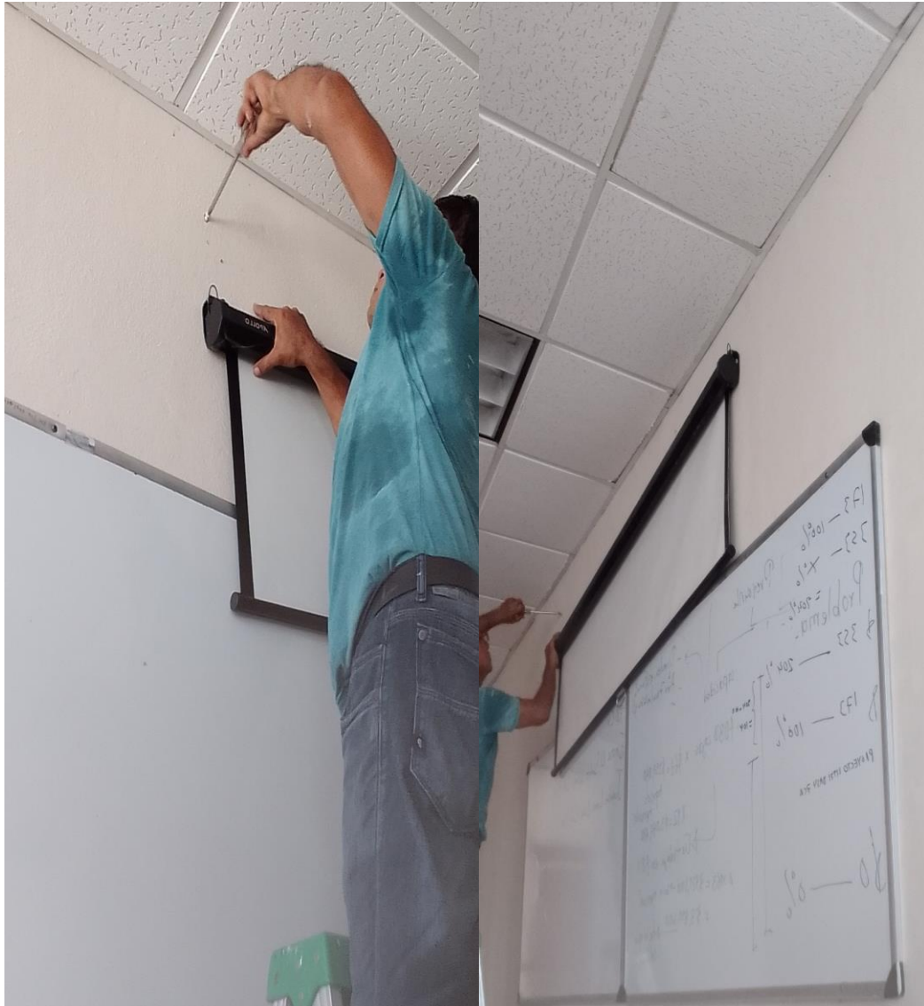
Figura 49. Mantenimiento en proyectores de aulas.
