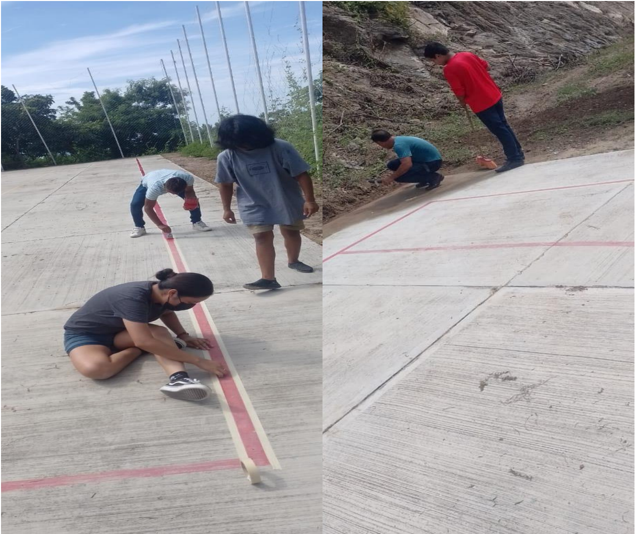
Figura 69. Mantenimiento de pintura en cancha de usos múltiples.
