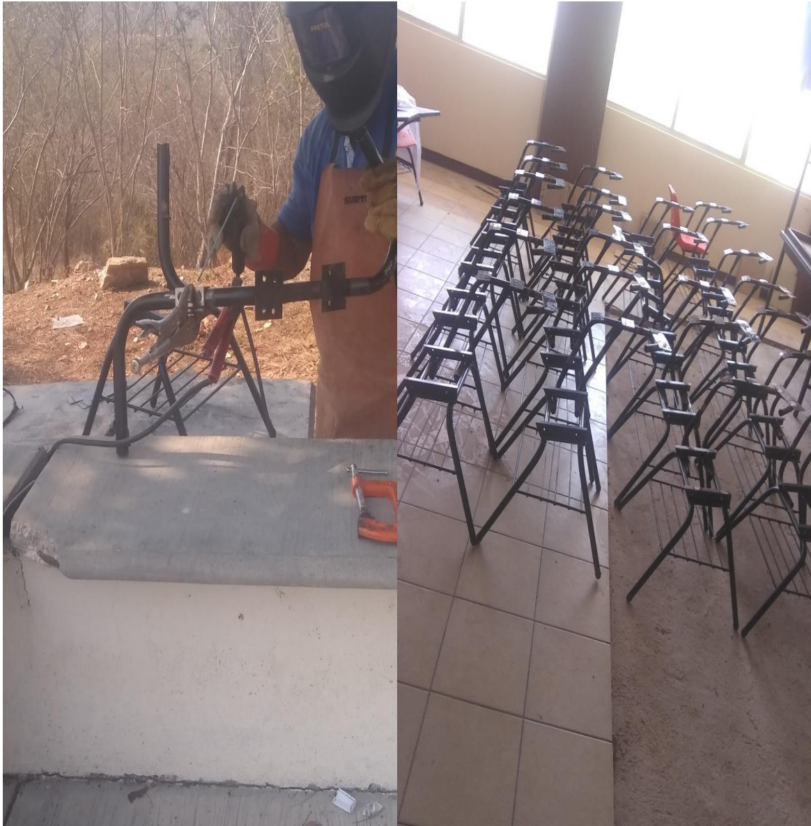
Figura 50. Mantenimiento en sillas.
